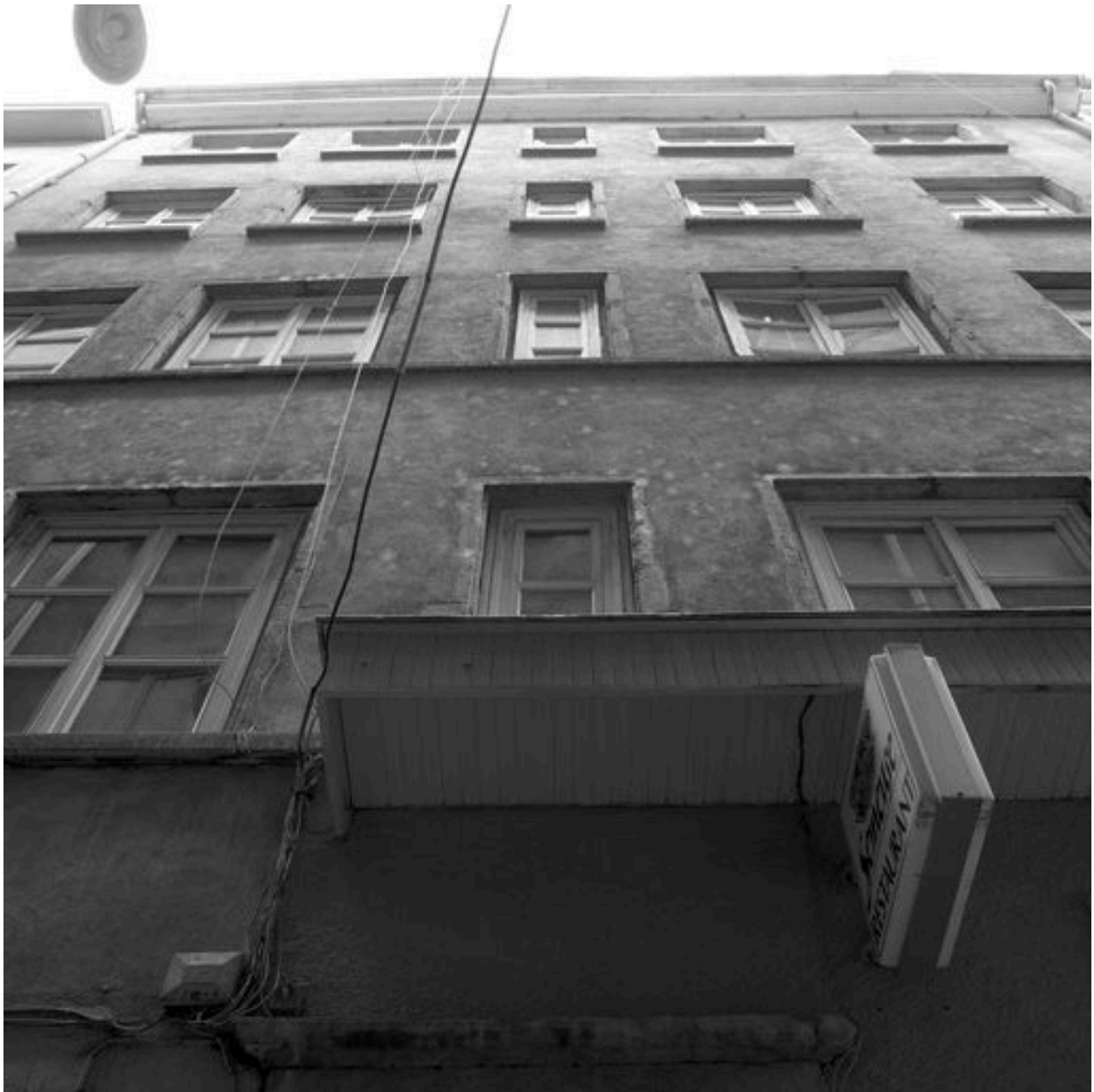
Façade, vue générale par-dessous
