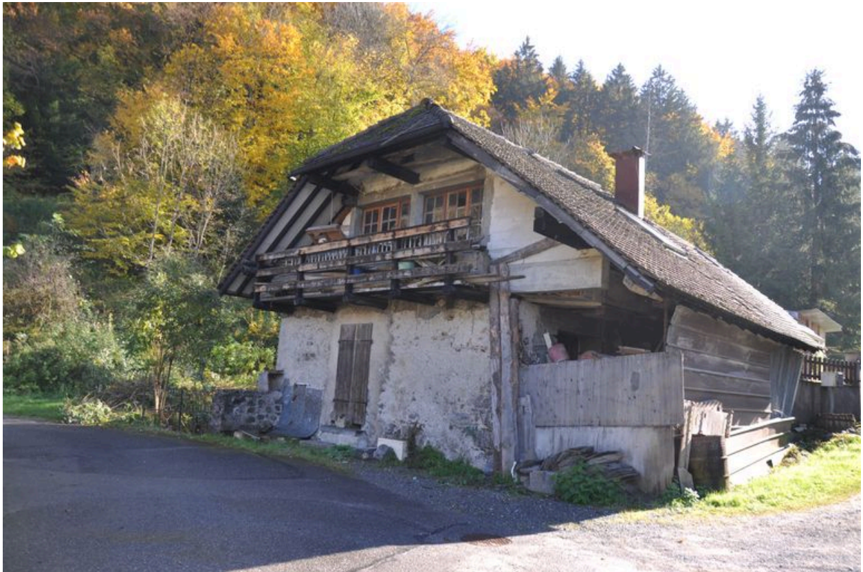
Élévation nord-ouest du bâtiment du moulin
