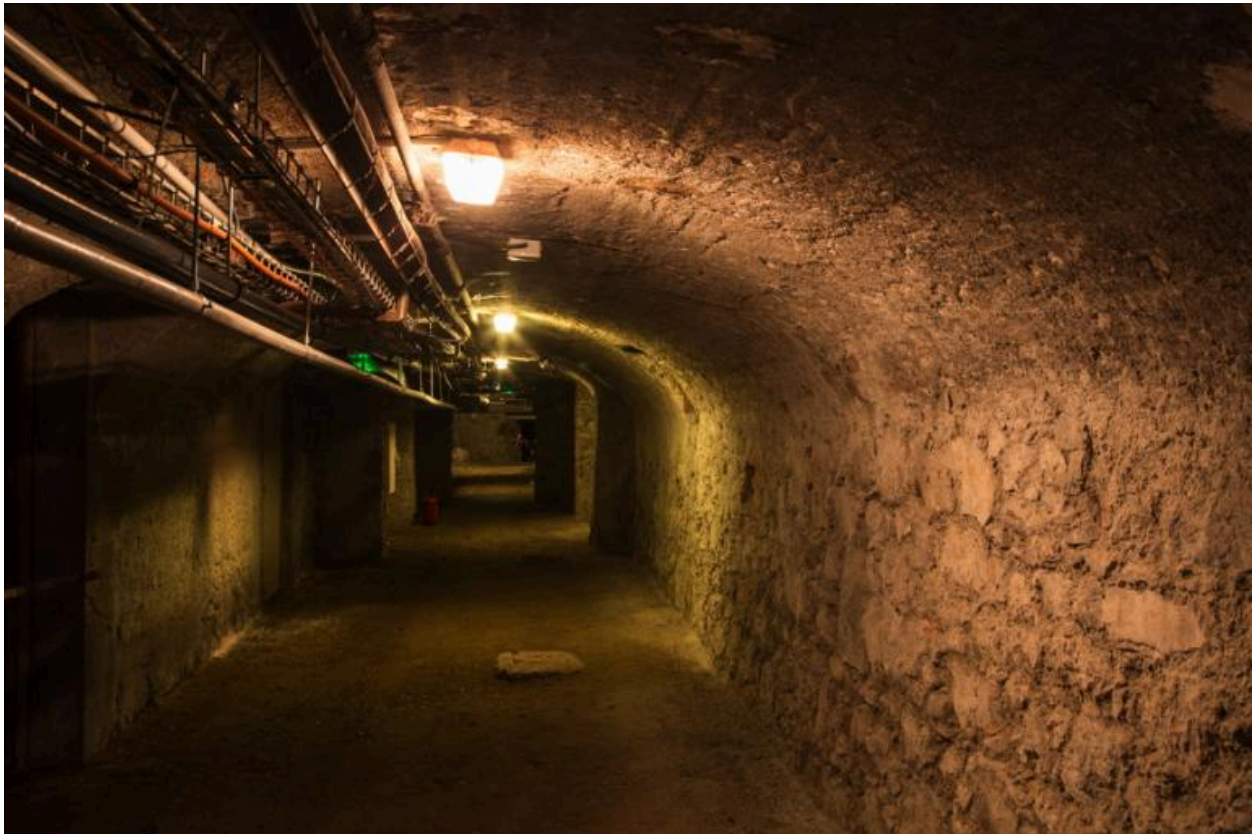
Bâtiment en H, les caves.
