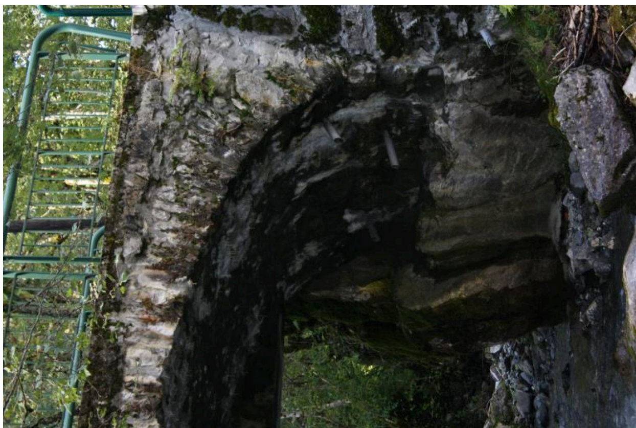
Pont de l'Envers, détail culée rive gauche, tympan et bandeau face amont
