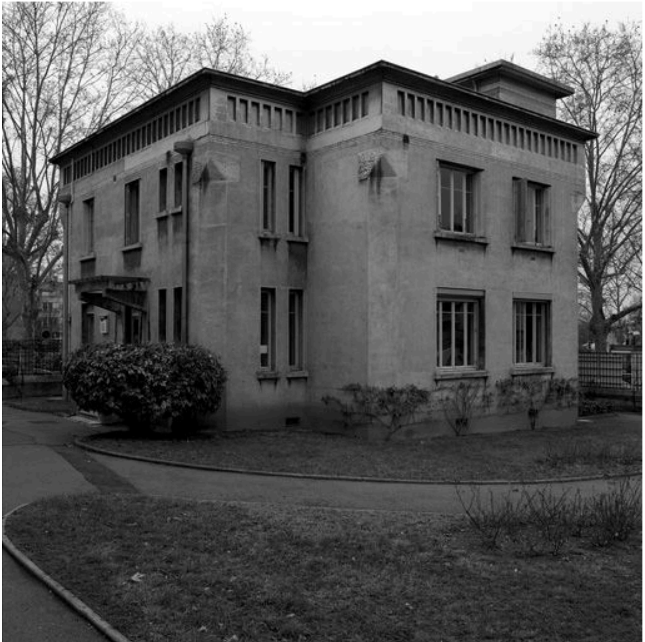
Le bâtiment 16, économat : vue depuis le jardin au nord-est
