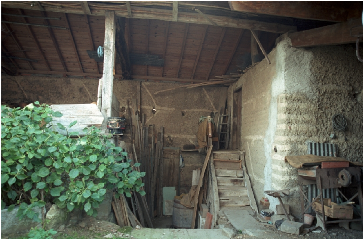
Vue partielle des communs, escalier descendant à la cave, escalier montant au logement.
