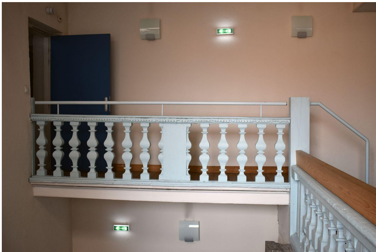
Escalier F : passerelle donnant accès au comble
