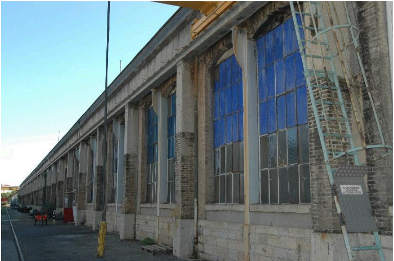
Vue extérieure des ateliers
