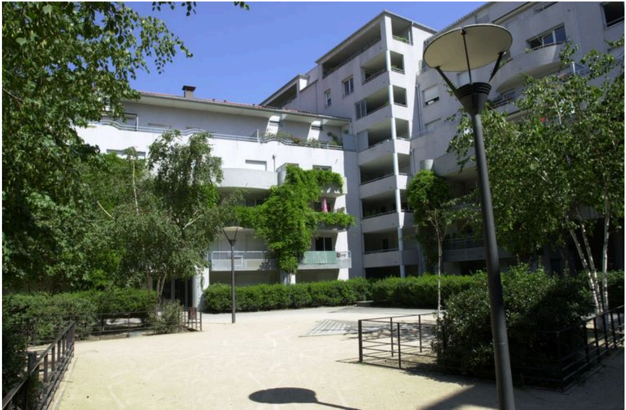
Elévations postérieures sur le square
