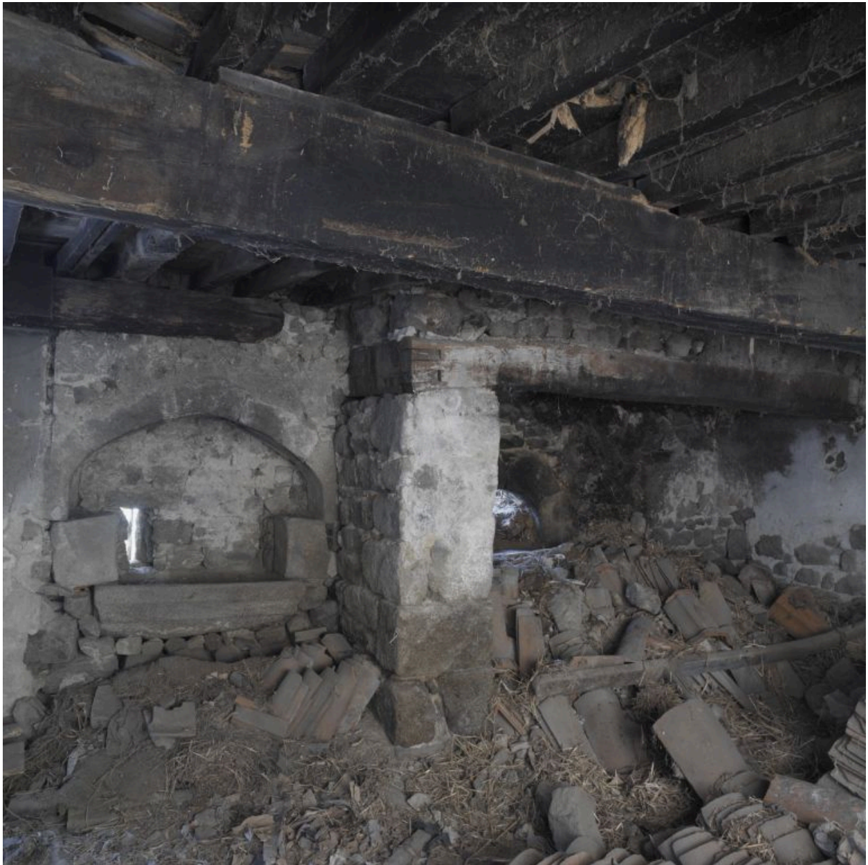
Vue intérieure du rez-de-chaussée du logis 4 : évier et cheminée.
