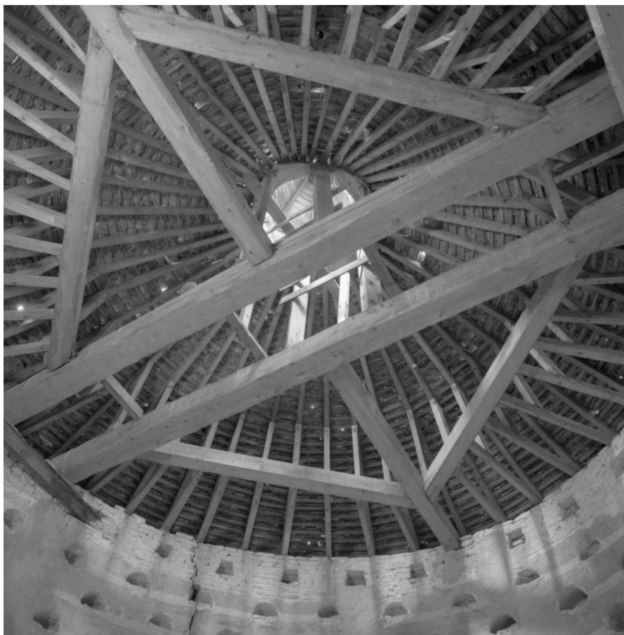
Vue intérieure de la charpente du colombier.
