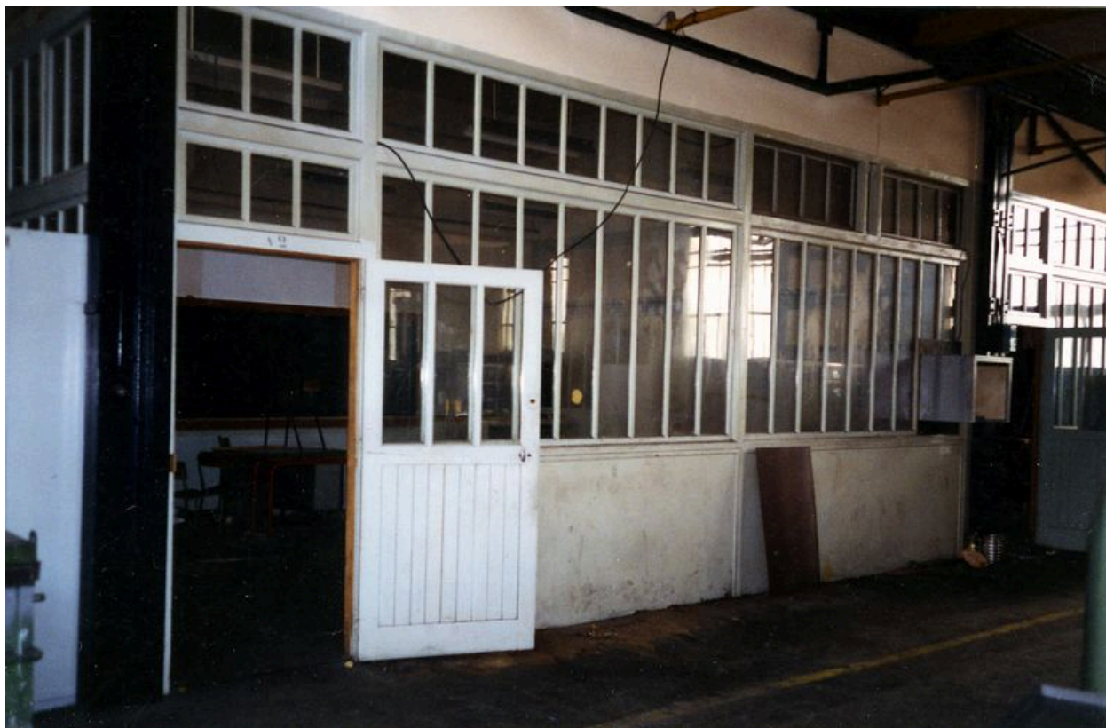
Intérieur d'un ancien atelier avant sa démolition, 1995
