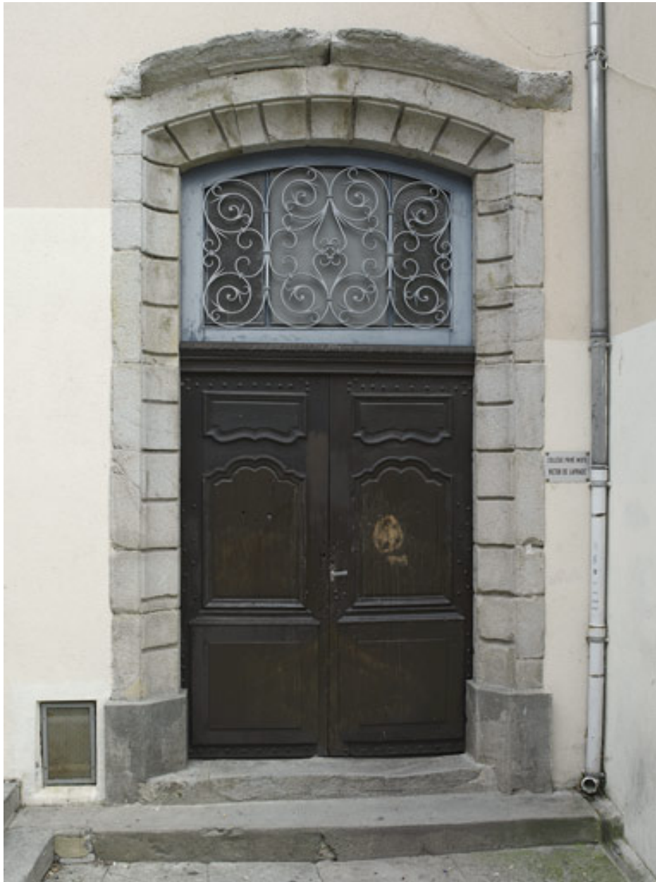
Bâtiment A : porte d'entrée du 2e quart du 18e siècle.
