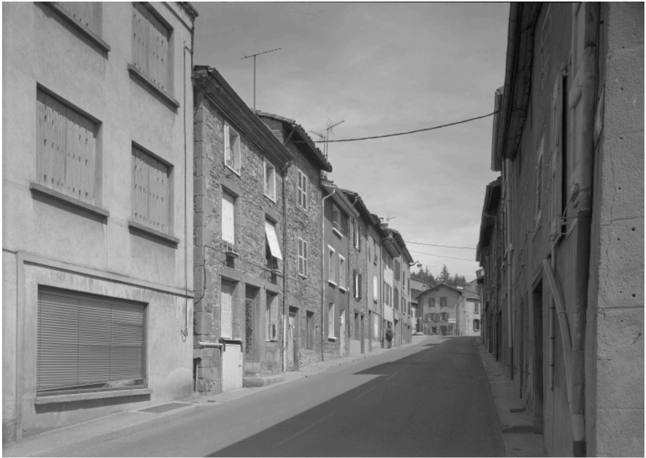
Vue de la rue de Roanne, au-delà de la place Rolle, du sud-ouest.
