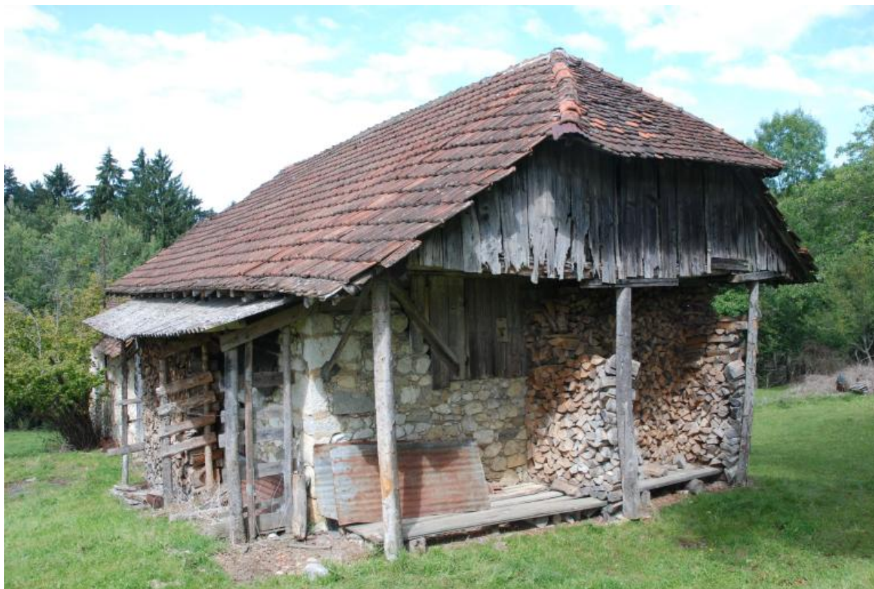
Vue d'ensemble du pignon ouest.
