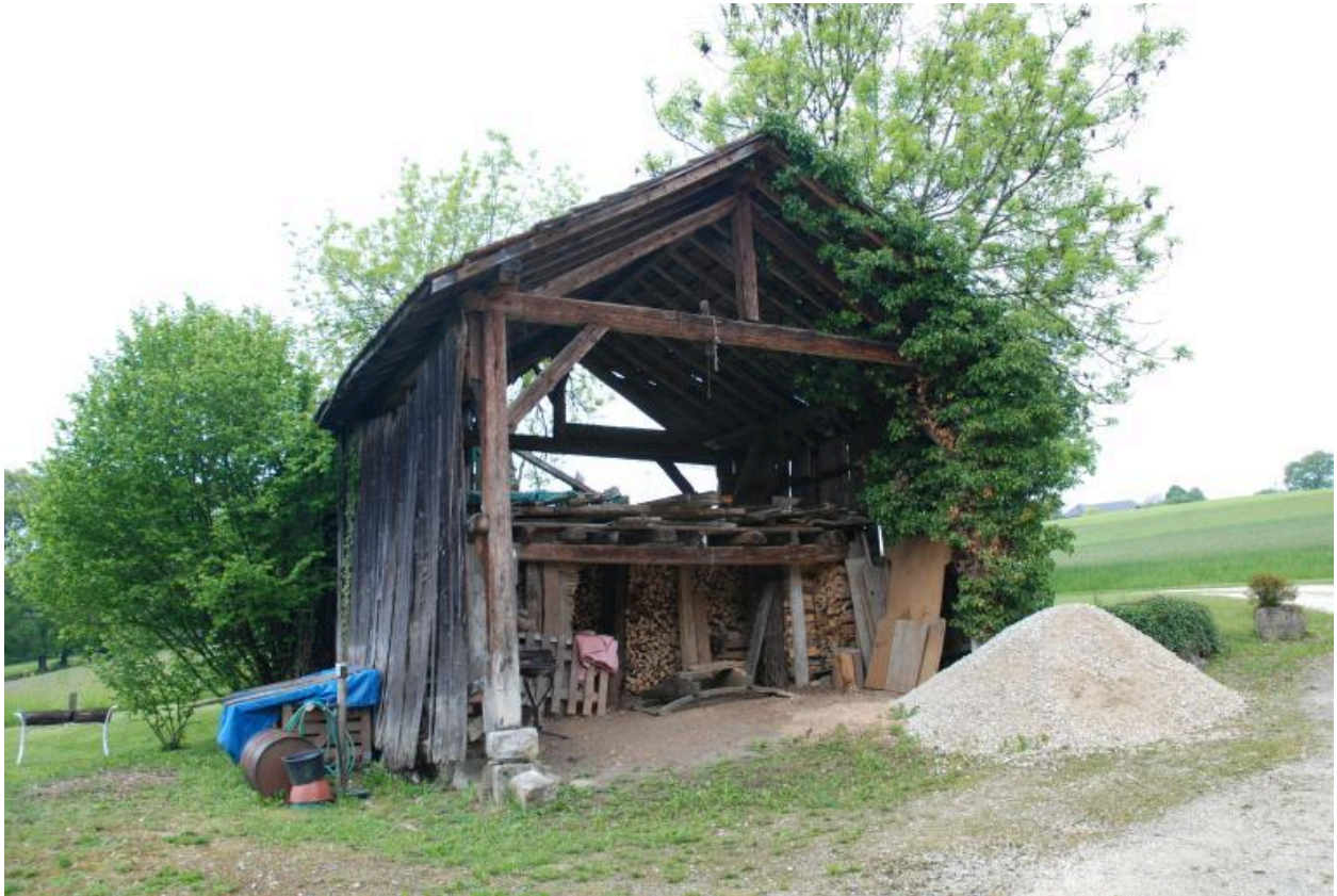
Vue de la remise en charpente.
