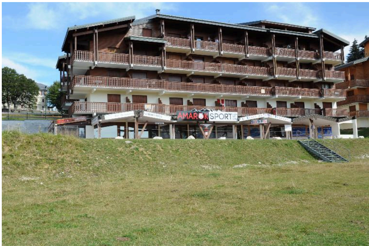
Immeuble Les Belledonnes : façade sud
