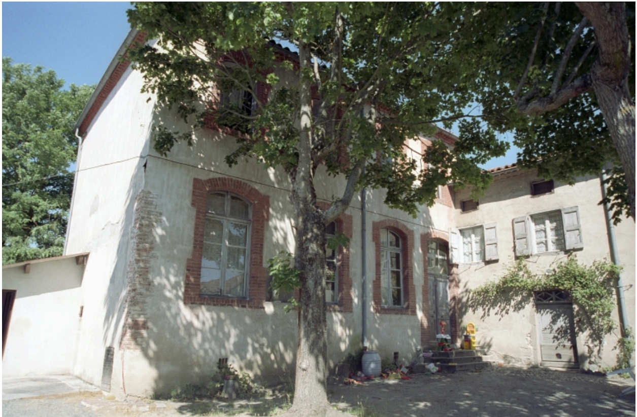
Bâtiment en retour contenant les salles de classe, depuis le sud-est.
