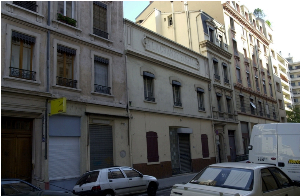
Vue d'ensemble est-ouest, atelier et immeuble patronal
