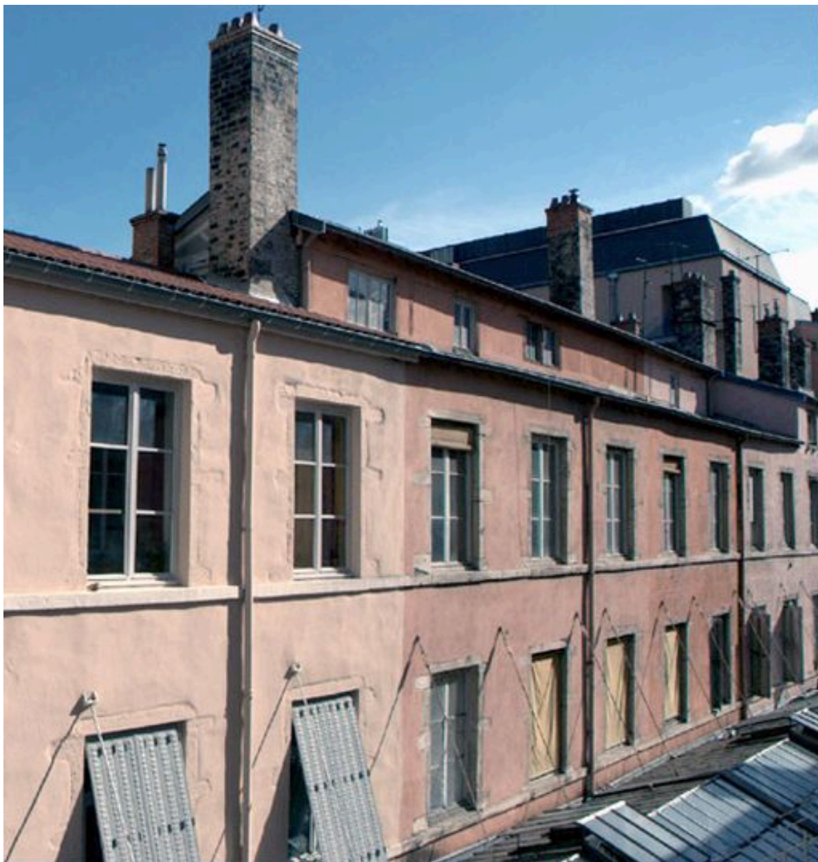
Vue de l'élévation antérieure depuis le sud-ouest
