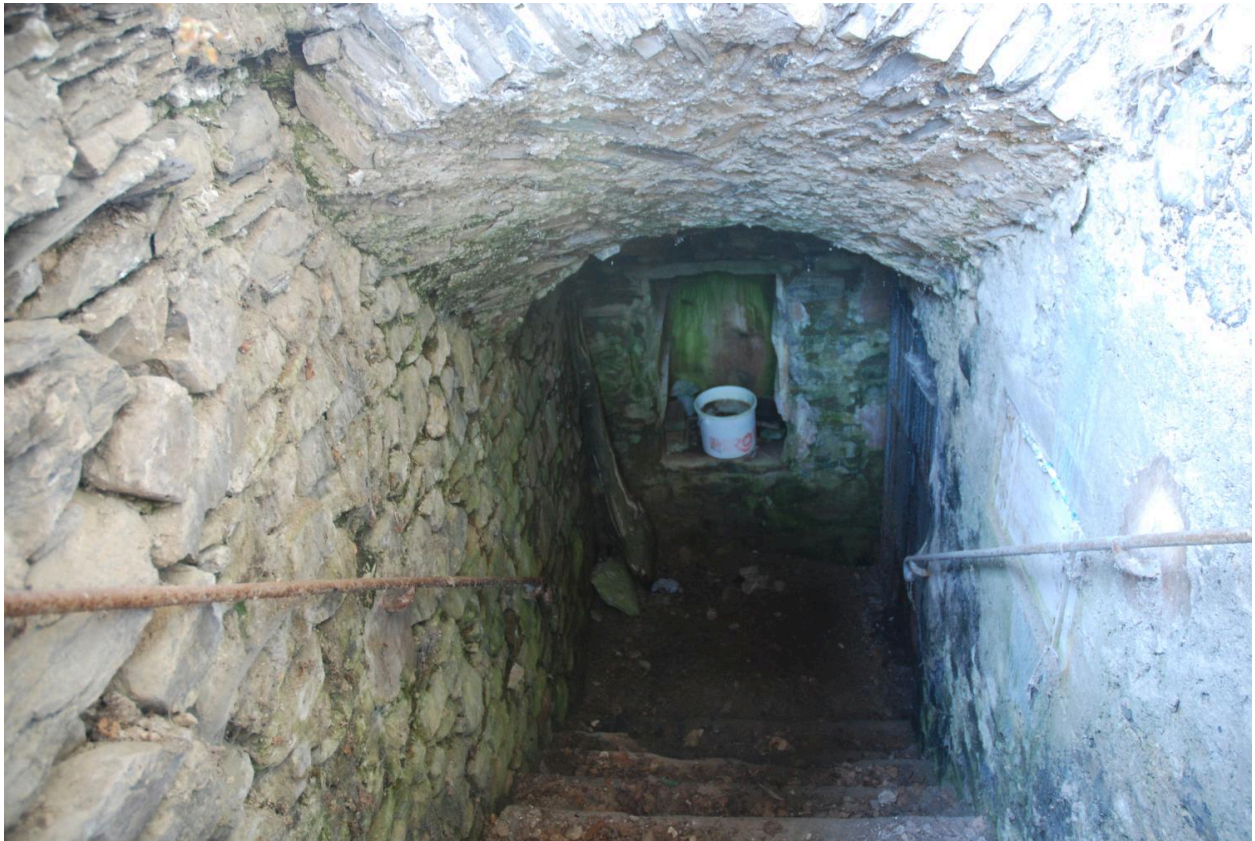
Rue de la Fruitière, maison de vigneron (2018 H2 527) : descente de cave à couloir voûté.
