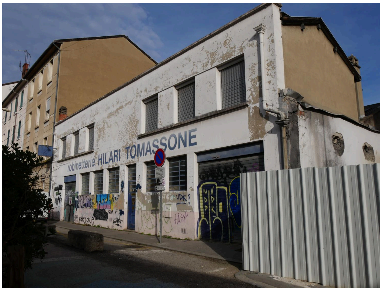
Vue d'ensemble robinetterie
