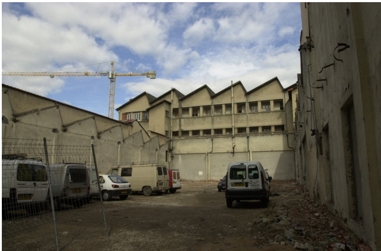
Site en cour de démolition
