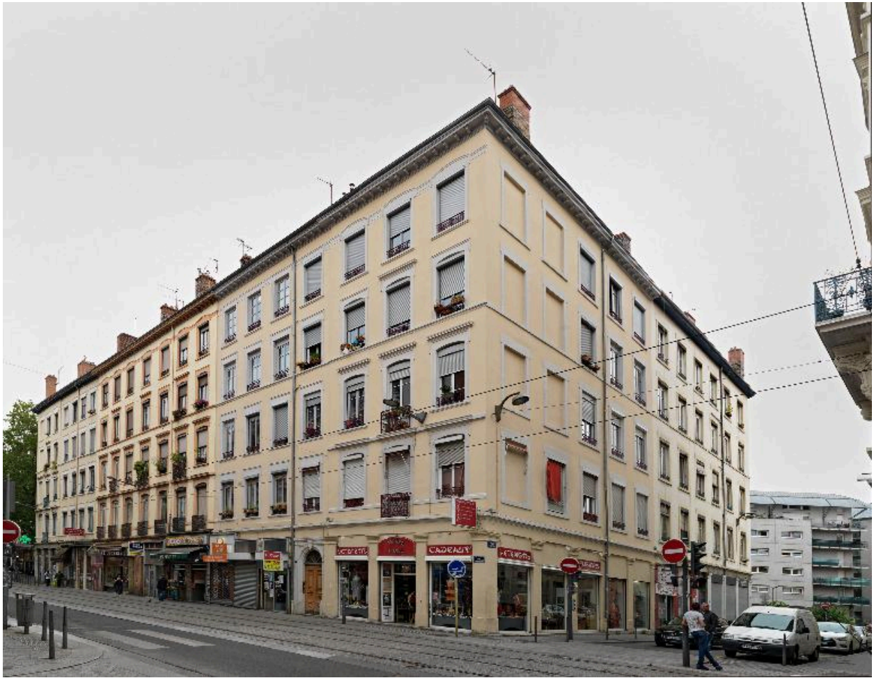
Vue d'ensemble de l'ilot, depuis la rue de Marseille
