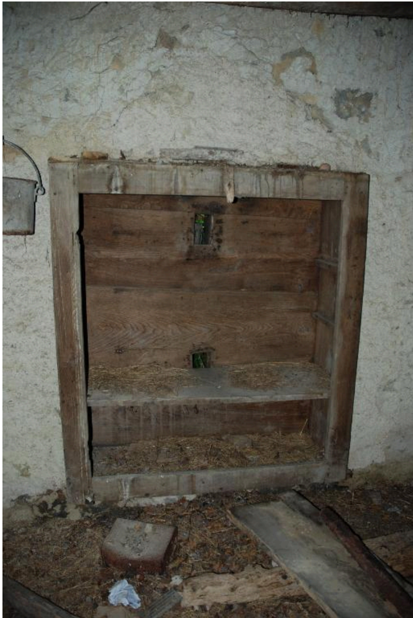
Vue intérieure du cellier : placard avec jours de ventilation.
