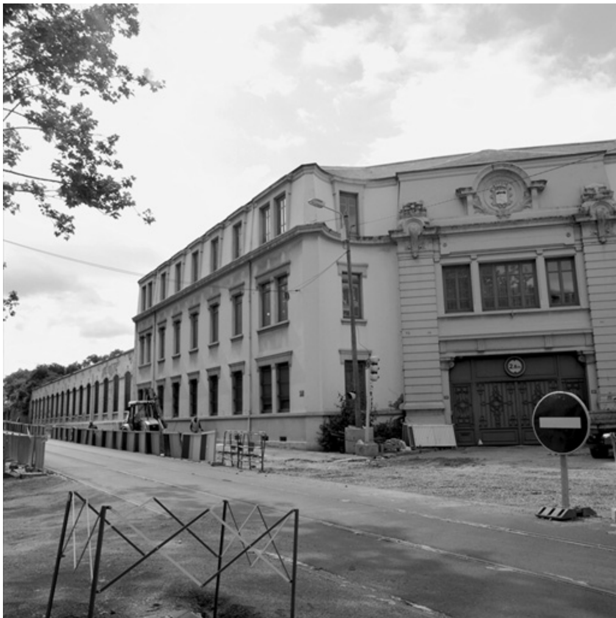
Vue de la façade nord
