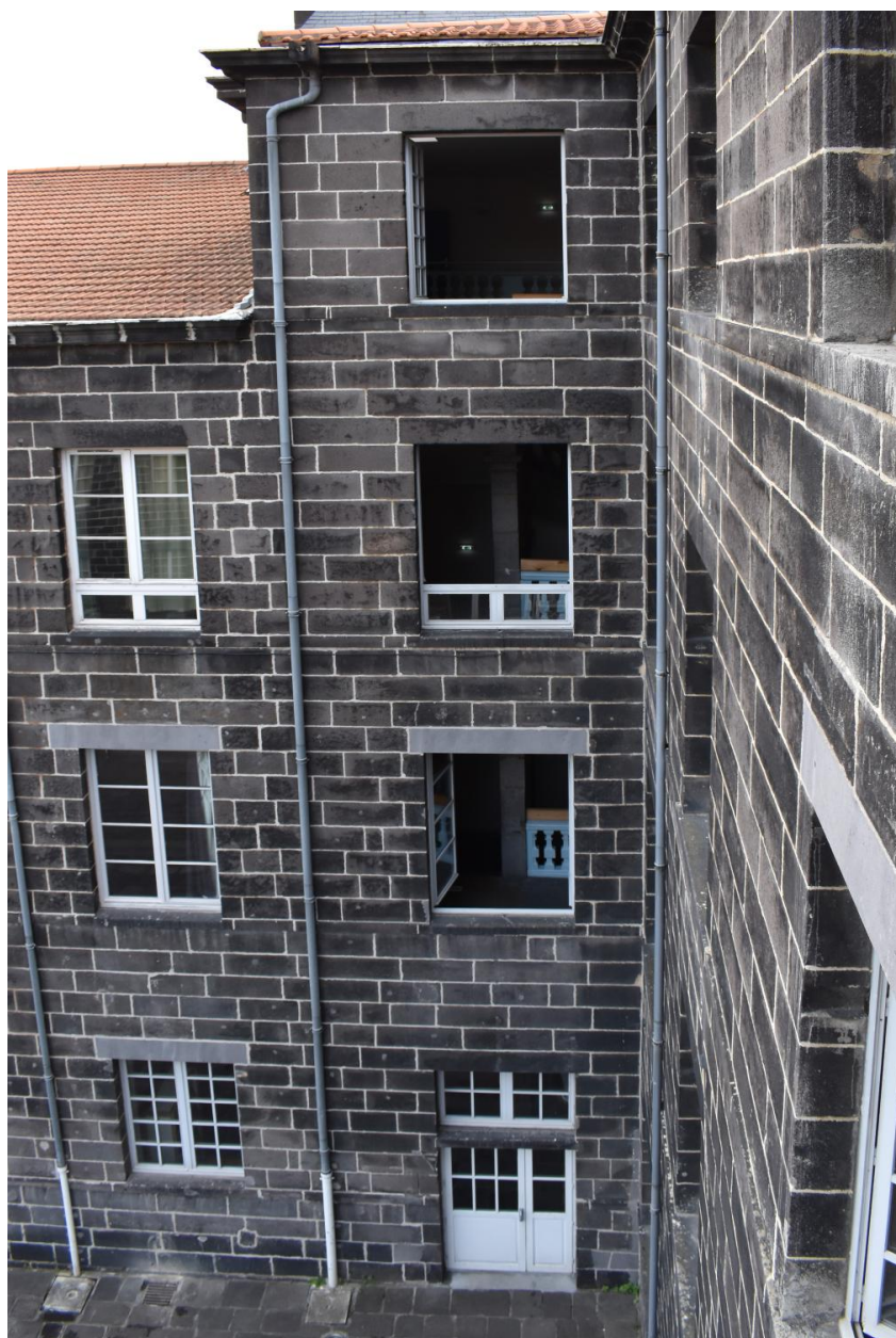
Bâtiment A, pavillon est : détail de la travée sur la cour d'honneur
