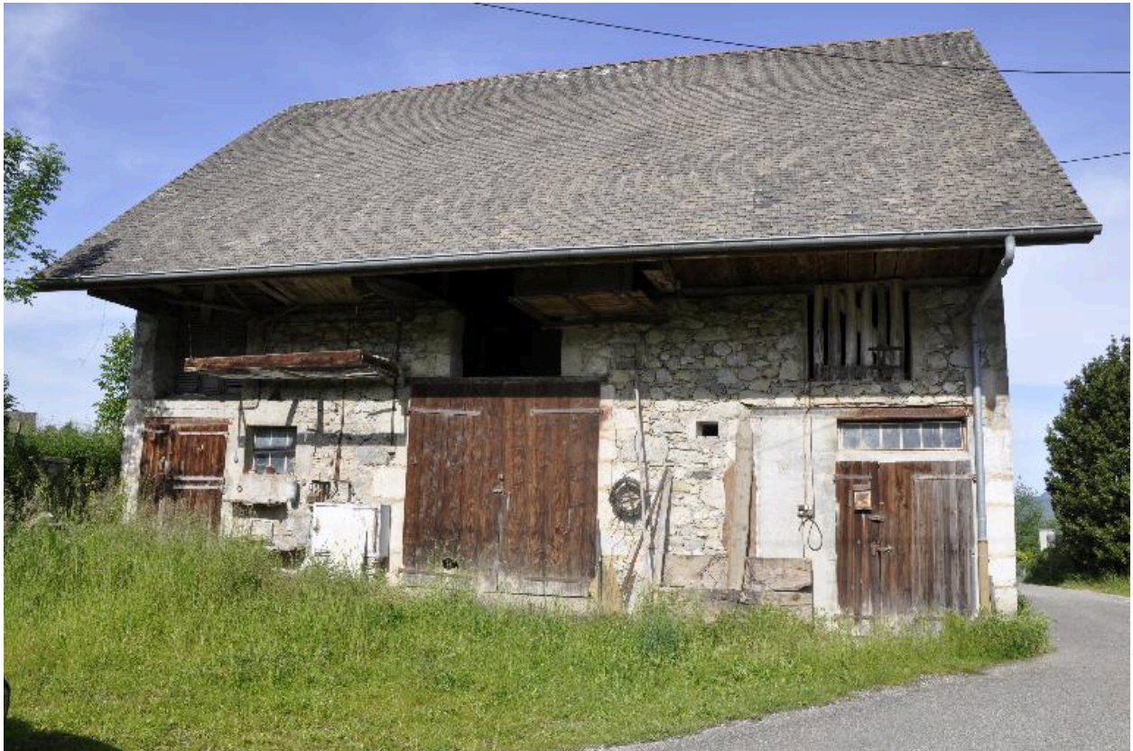
Vue d'ensemble de la grange-étable 2013 D1 1, non repérée.
