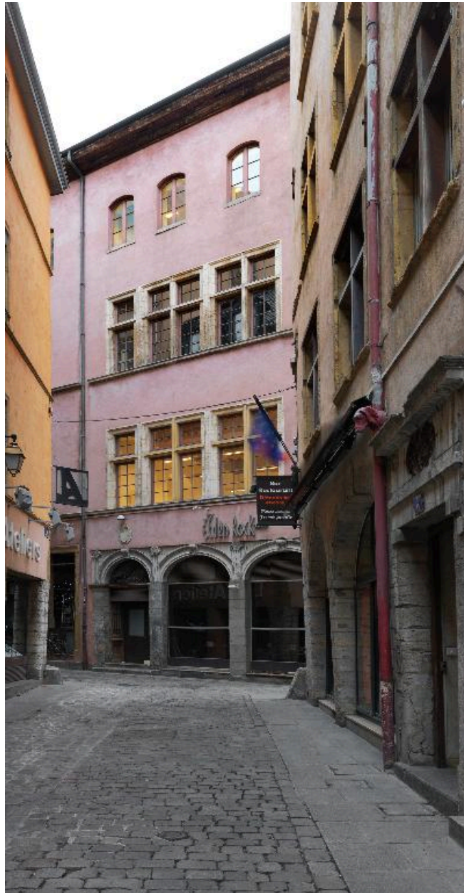
Vue partielle de l'élévation rue de la Monnaie depuis la rue du Petit-David
