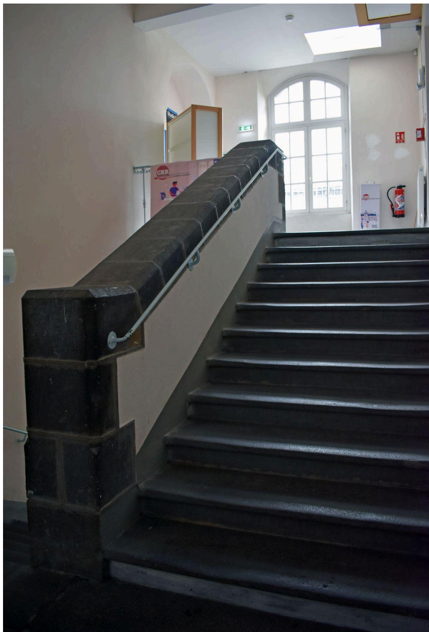
Bâtiment B : escalier C, dernière volée
