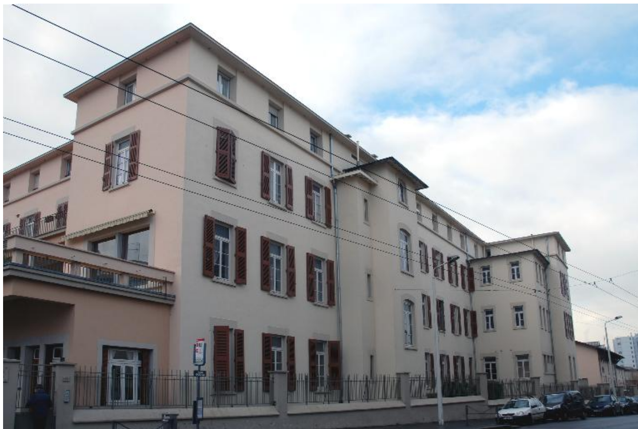
Aile nord : élévation sur rue depuis l'est
