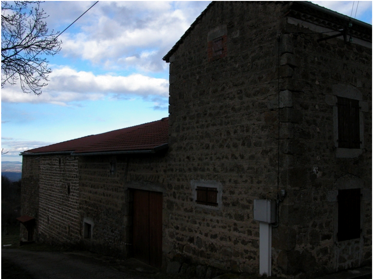
Vue générale arrière.
