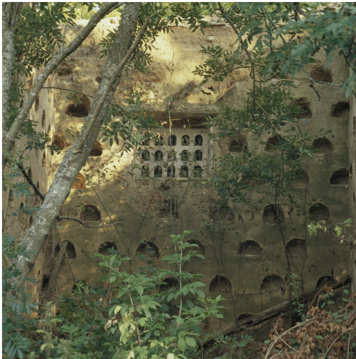
Détail des trous de boulin du pigeonnier.
