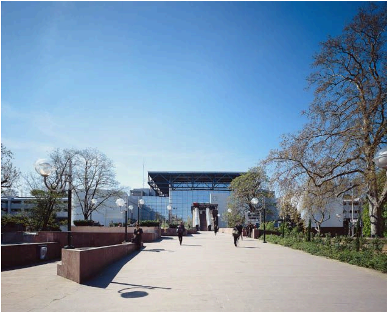
Rampe d'accès nord du centre d'échanges : vue depuis la place Carnot
