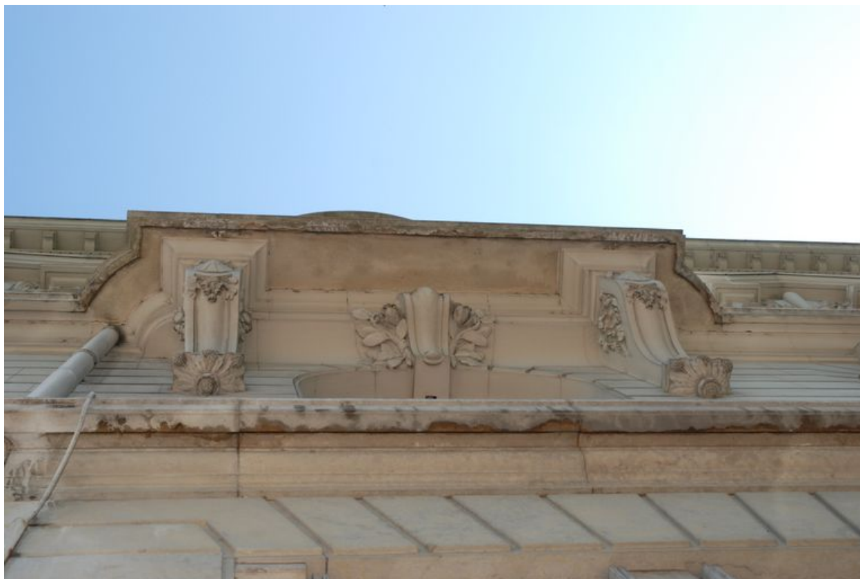
Détail du décor en pierre d'un balcon, vue en contre-plongée
