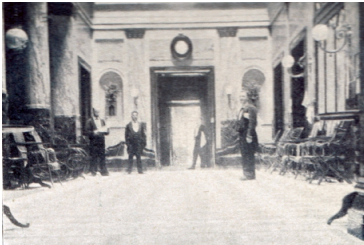
Le hall avant transformation
