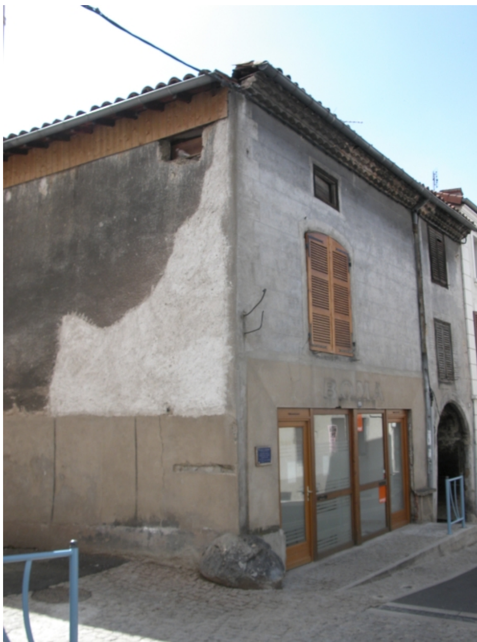
Îlot 2. Roanne (rue de) 13, 15. Vue générale des façades sur l'angle.
