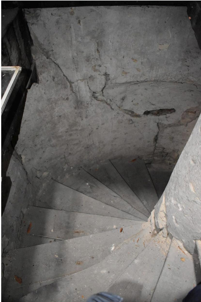
Etage de comble. Descente de l'escalier en vis en bois avec noyau central en pierre.
