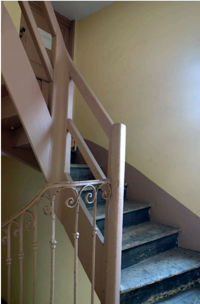
Départ de l'escalier vers le 3e étage
