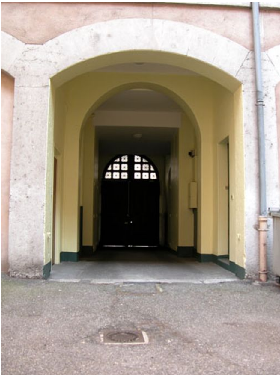
Vue du passage couvert depuis la cour
