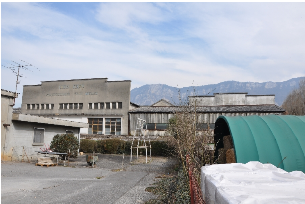
Ets Louis Girod, façades postérieures
