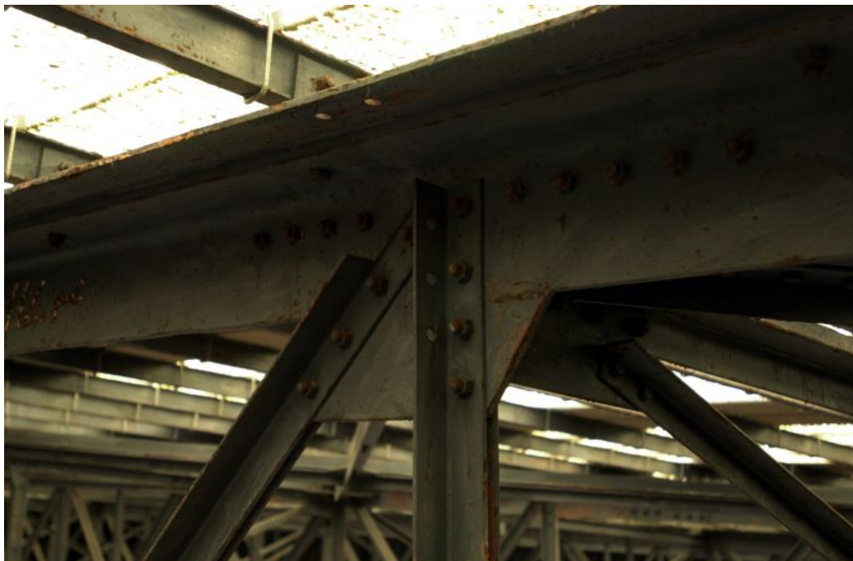
Détail de l'assemblage de la charpente métallique par boulonnage
