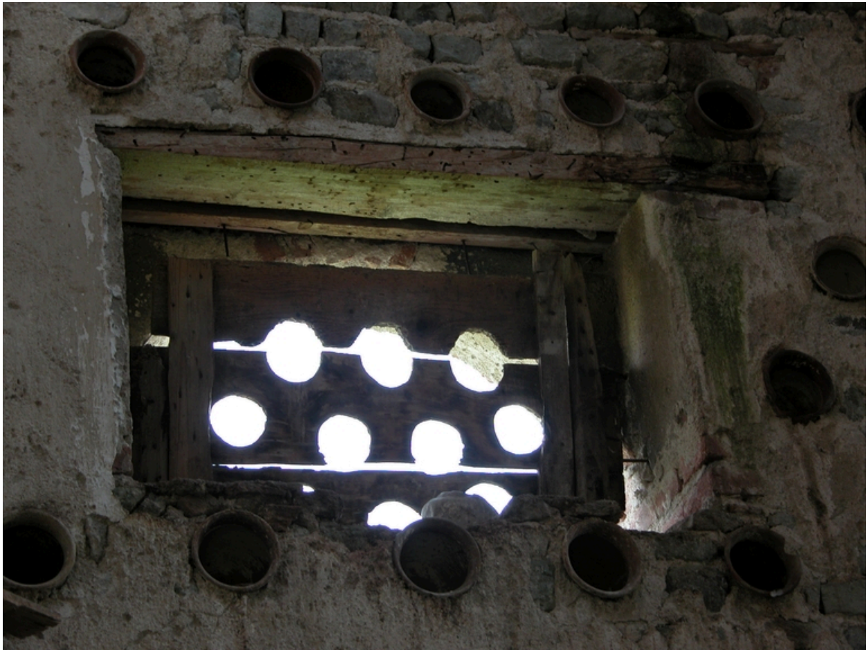
Vue intérieure du pigeonnier : détail des planches trouées en fermeture de fenêtre.
