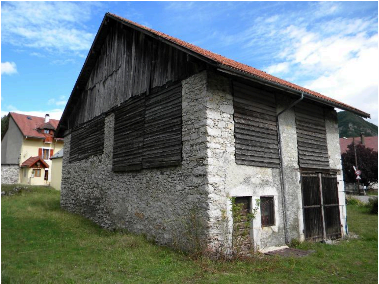
Vue de la façade arrière
