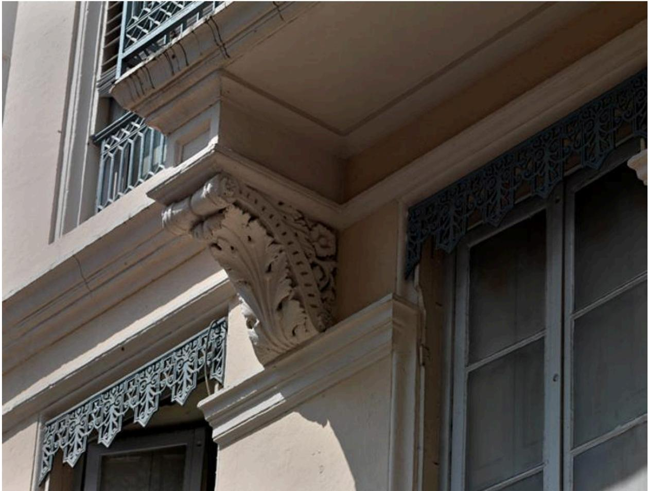
Élévation antérieure rue de Brest, travée axiale : détail d'une des consoles feuillagées supportant le balcon du deuxième étage carré
