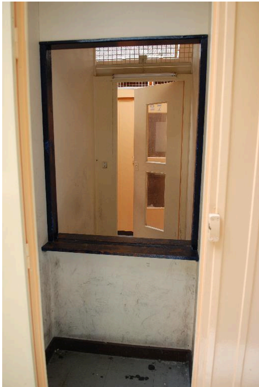
Etat en 2010 : partie sud, l'un des parloirs ajoutés dans la deuxième moitié du XXe siècle
