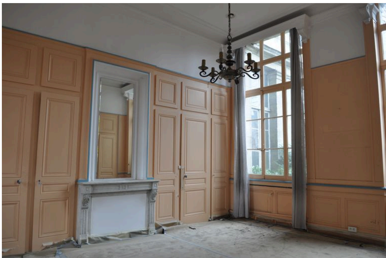
Vue de l'ancien cabinet de la directrice, en 2010, durant les travaux de transformation.
