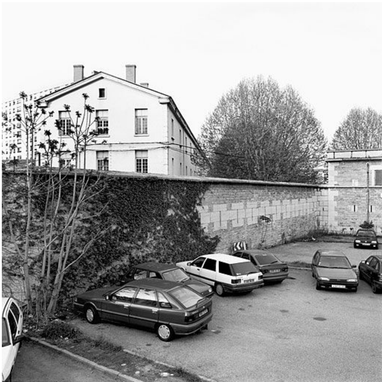
Mur d'entrée de la caserne
