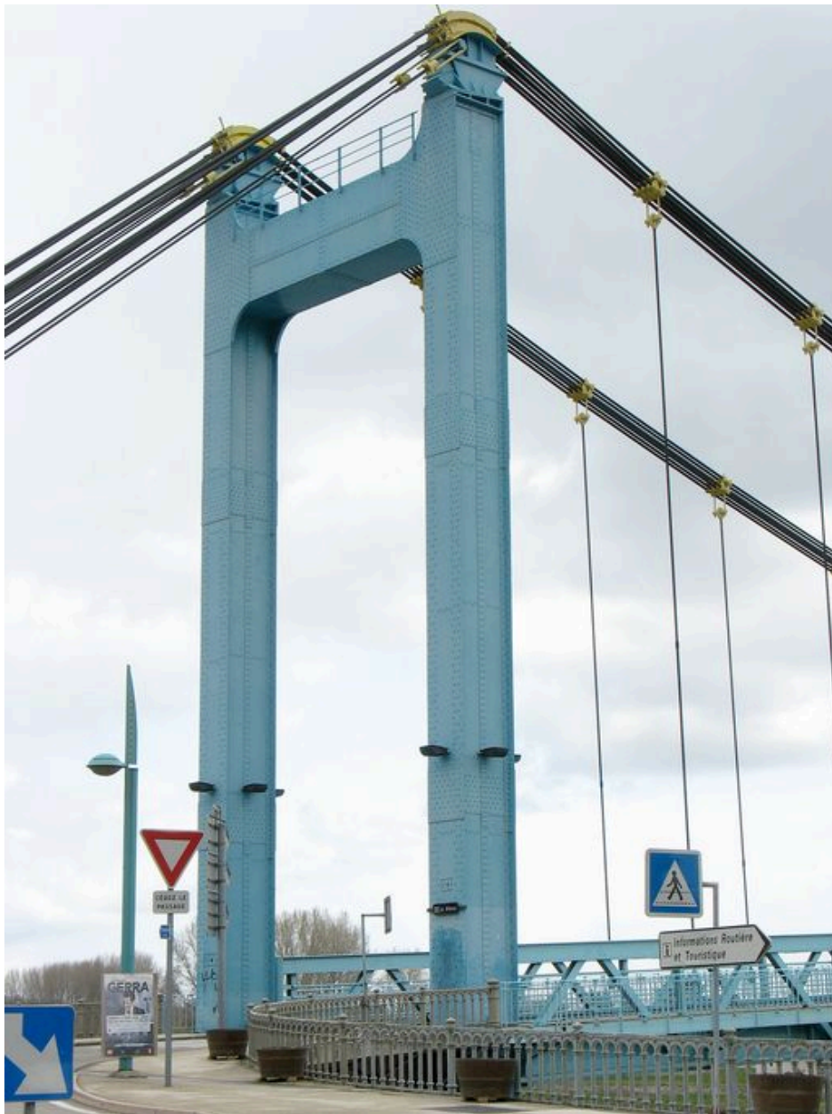
Vue du pylône de la rive droite (partie au-dessus du tablier)
