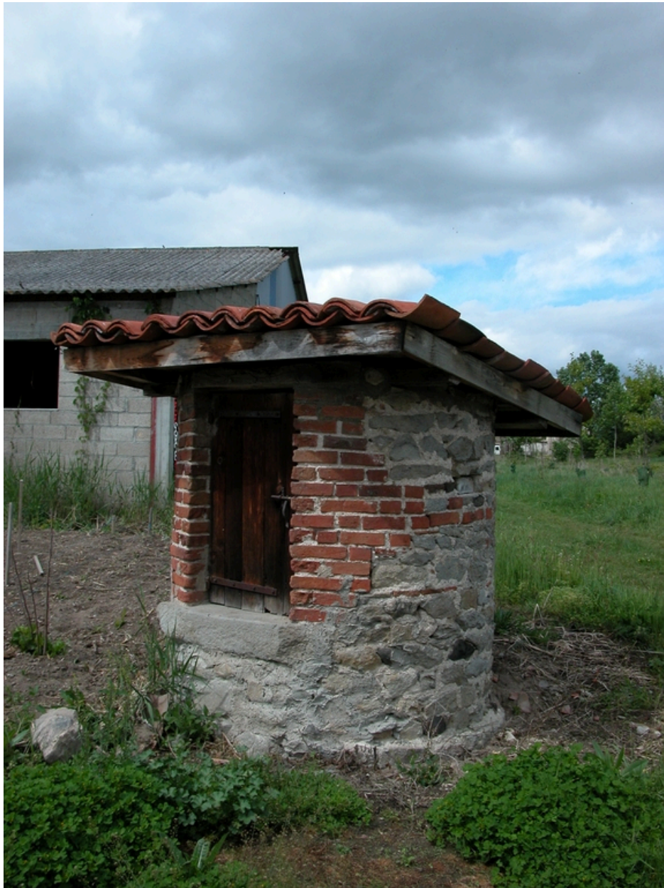
Vue du puits ouest.
